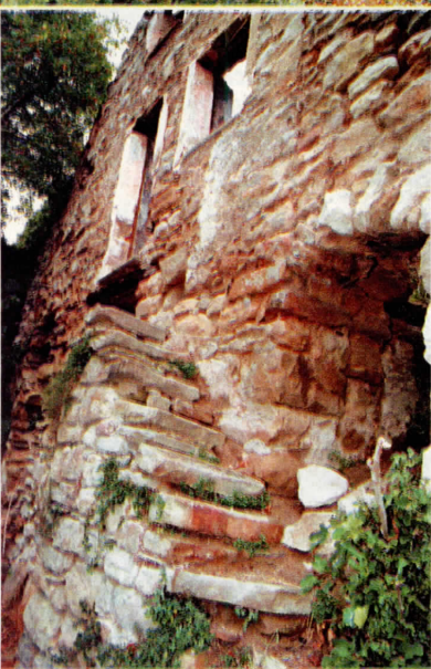
Des vestiges d'habitation.
